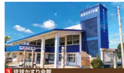
3 琉球かすり会館
