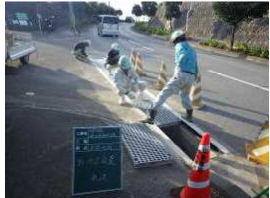
▲老朽化で腐食したグレーチングの補修作業状況
