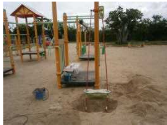
▲本部公園遊具取替完了状況
