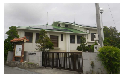
神里地区農業集落排水処理施設▲
