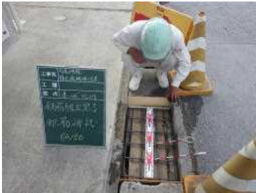
▲破損した排水溝の補修作業状況
