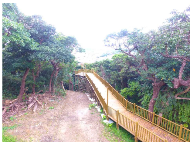
▲遊歩道工事状況
