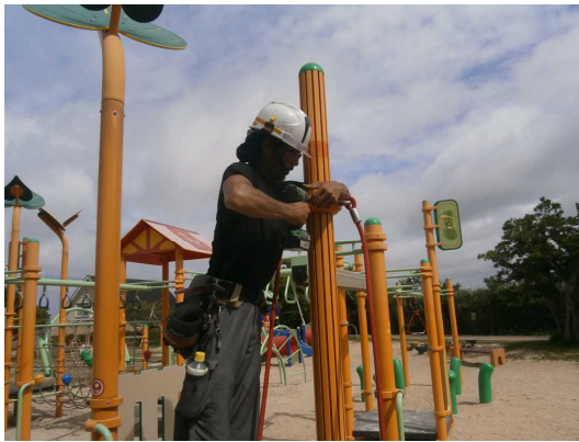
▲本部公園遊具取替作業状況
