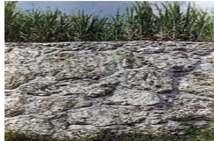
↑ 石積みのすき間を埋めて環境整備を
