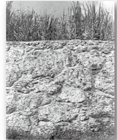
穴埋めされた石積み
