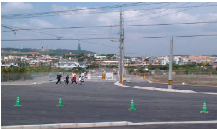
南風原中学校体育館側から宮平土地改良区へ
