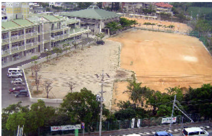
南風原小学校運動場を整備します
