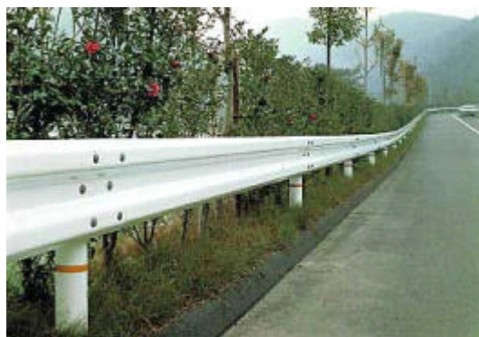
ガードレール設置例
