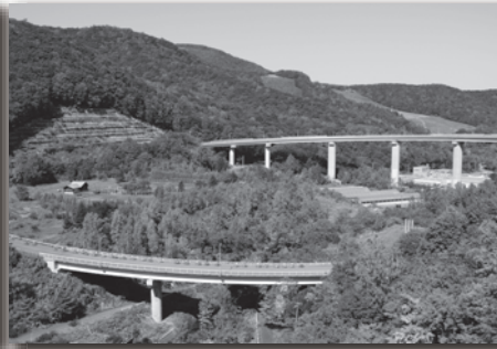
朝里ダム朝里スカイループを走る隊列38km付近
