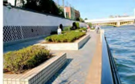
(上) 現代の浅草御蔵跡。左に見える隅田川のコンクリート堤防が、お米蔵の土蔵のなまこ壁を模して化粧されている。前方の橋は蔵前橋。筆者撮影。
