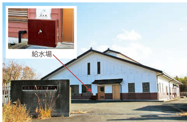
警備の拠点となる小良ヶ浜浄化センター（点拠点）
