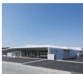
深谷工場外観
