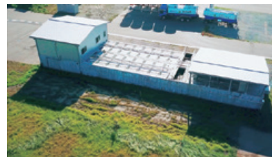
排水処理システム
