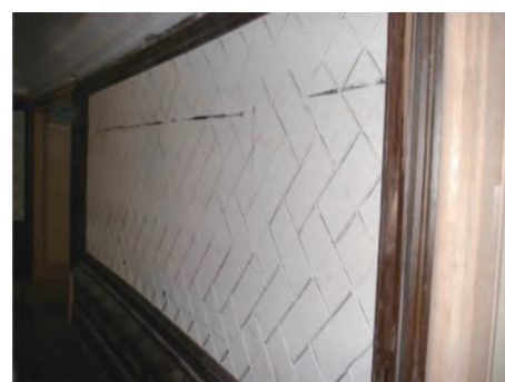
写真-3 1F 後壁施工状況
