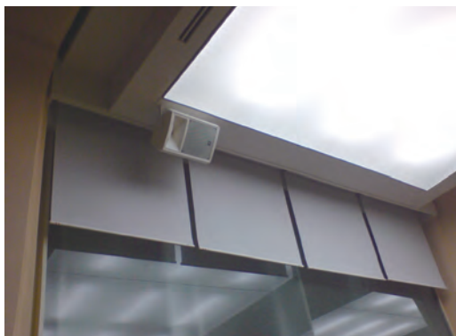
写真-8 吸音スクリーン取付状況
