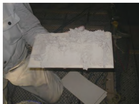
写真-2 セロテックス代替品 (虫食い模様なし岩綿吸音板) 貼り付け前
