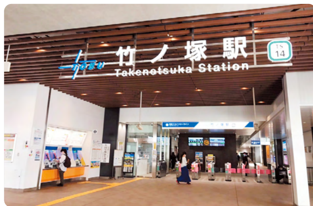
竹ノ塚駅改札口天井照明
