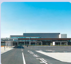
庁舎建設工事 (東武建設)
