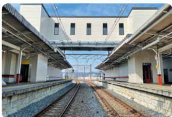
エレベーター (新桐生駅)
