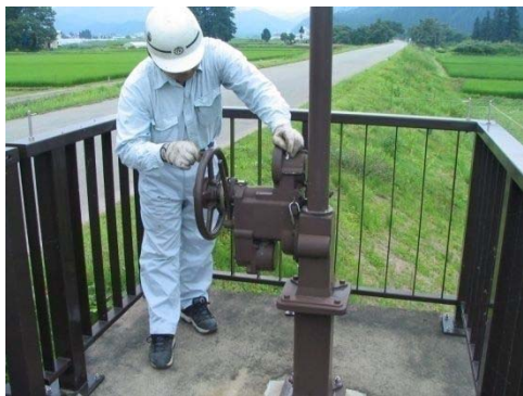
施設点検（樋門ゲート設備）の状況
