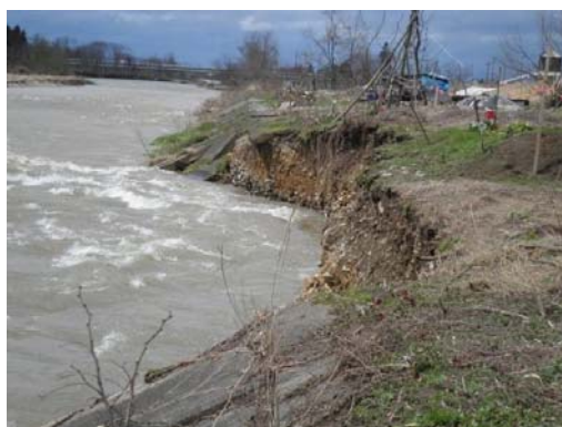
護岸の損傷
