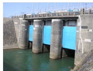
新屋水門（改築前）
