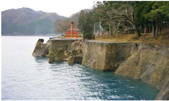
水位の低下により悪化した景観
