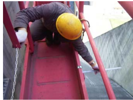
放流設備点検状況
