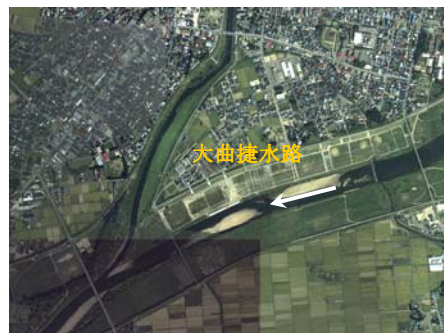
大曲捷水路完成後（平成22年）
