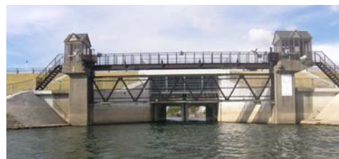
新屋水門（改築後）
