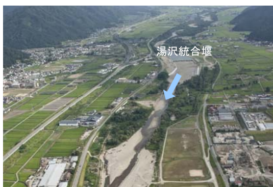
雄物川上流部の砂州の状況
