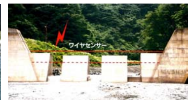
ワイヤセンサー 土砂移動検知センサー
