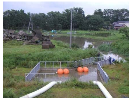
角間川排水ピット
