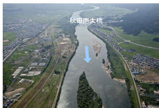
雄物川下流部の砂州の状況
