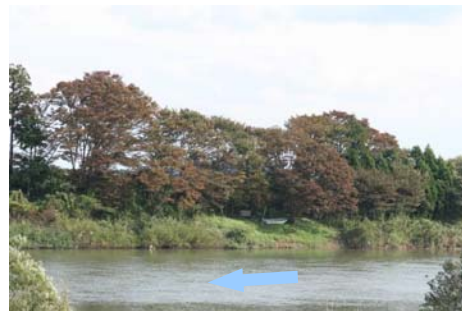
きょうゆうおおはし 協雄大橋付近の樹木の繁茂状況
