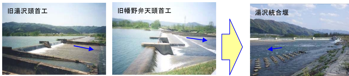
湯沢頭首工改修前後の施設状況
