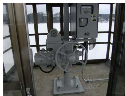
ゲート開閉装置の更新（手動→電動）
