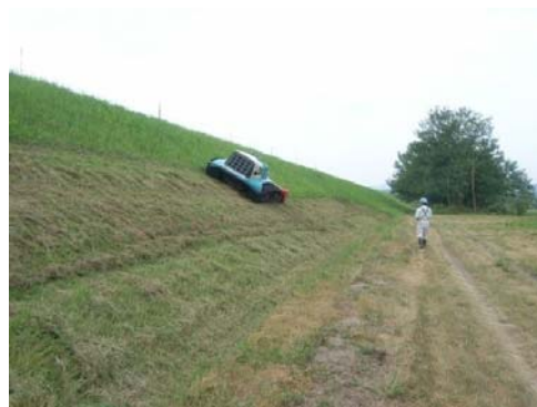
堤防除草作業状況
