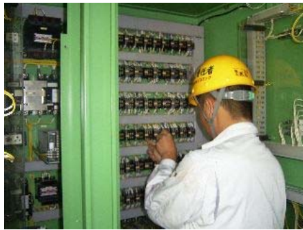
機側操作盤の点検状況
