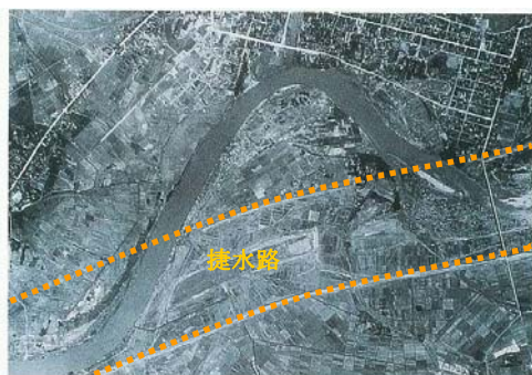
大曲捷水路改修工事中（昭和36年）
