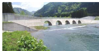
おほないがわ 生保内川大暗渠砂防堰堤
