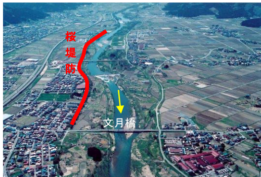
文月橋上流の桜堤防区間
