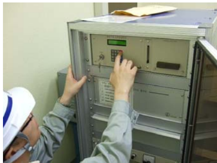
観測施設の点検状況
