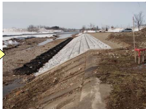
護岸の補修状況
