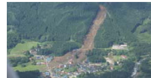
くようぶつ 供養佛地区被害状況（平成25年）
