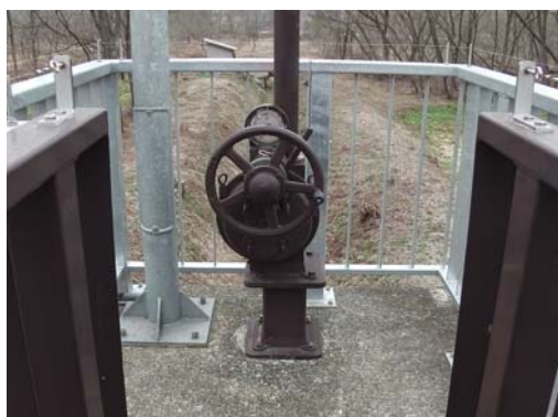
ゲート開閉装置の更新（手動→電動）
