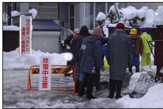
閉塞した河川の復旧作業を見守る住民
