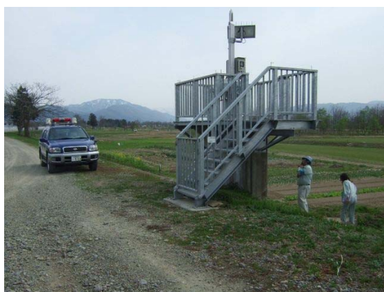
河川巡視(平常時)の状況
