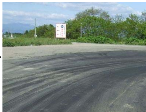
堤防の天端舗装補修後の状況
