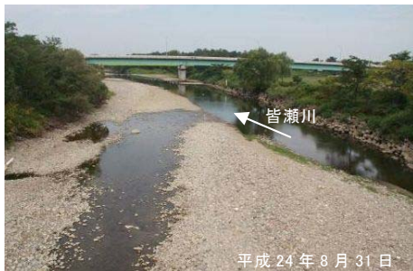
⑤ 岩崎橋地点の状況(平成24年8月:横手市、湯沢市)
