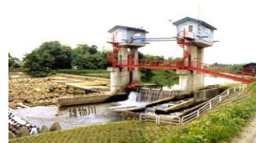
大久保頭首工（改築前）
