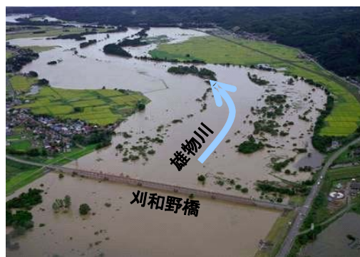
平成 19 年 9 月洪水写真 (刈和野橋地点)
