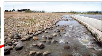
粗石付き斜路式魚道
