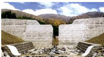
くろきわ 黒沢第1砂防堰堤
