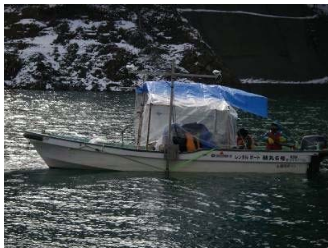
ダムの堆砂測量の様子
