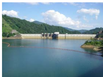
玉川ダム 流木止施設
