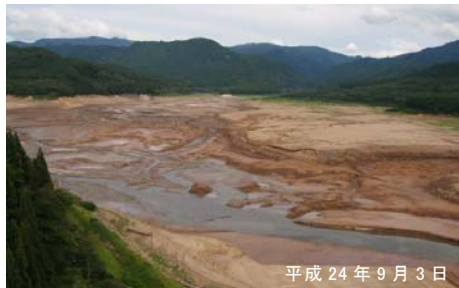
⑥ 玉川ダム貯水池の状況 (平成24年9月:仙北市)
