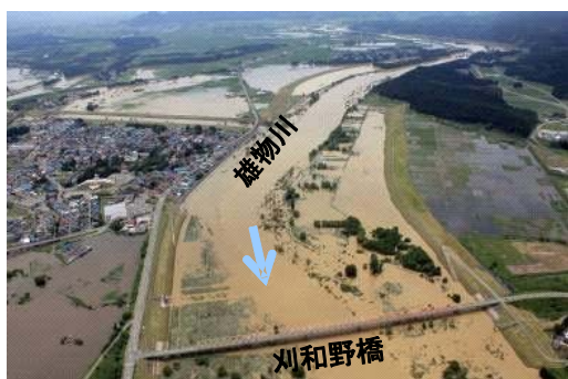
平成 23 年 6 月洪水写真 (刈和野橋地点)
