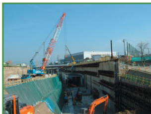
福岡外環状道路福大トンネル 新設第4工区工事 (福岡県福岡市)
