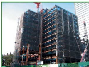
(仮称)東京ミッドタウン プロジェクト(B・E棟)新築工事 (東京都港区)
