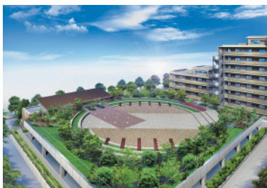
有楽土地(株) 首都圏最大のマンション建て替え事業である「オーベルグランディオ萩中」。 駐車場棟屋上には「セントラルガーデン」を設置(東京都)
