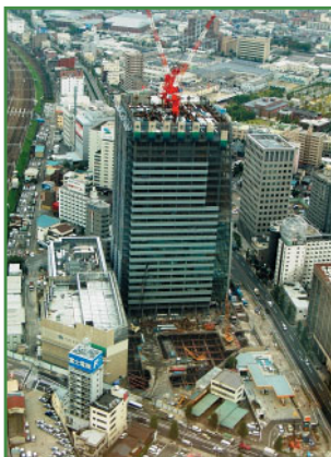
牛島再開発事業第2期工事 (愛知県名古屋市)
