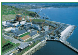
泊発電所3号機増設工事のうち 原子炉建屋他新築工事 循環水ポンプ建屋新築工事 海水淡水化設備建屋新築工事 取水設備工事 (北海道古宇郡)
