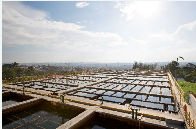
サンパウロ州 上水処理場
