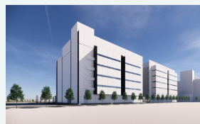
netXDC千葉第三センター
