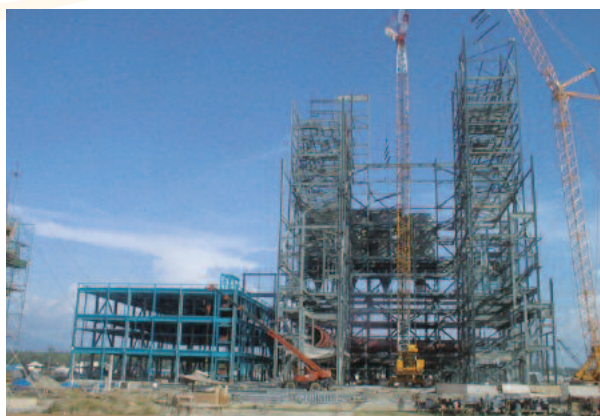
建設工事中(工事中断前)の発電所概観
