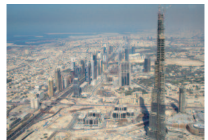
建設中の高層ビル(ドバイ)
