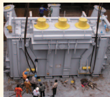
主変圧器の荷降ろし
