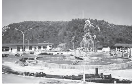
写真-3 土岐川右岸に建設された上山浄水場
