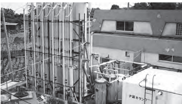
濾過脱塩塔（フリフロ・フィルタ）後は脱塩浄水場建物
