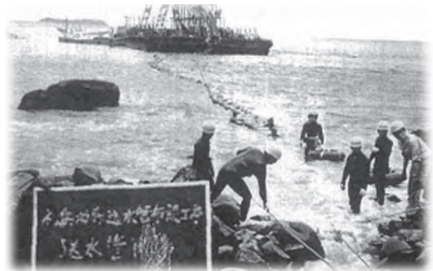
海底送水管布設作業（熱海側）
