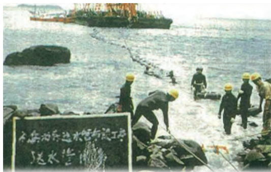
海底送水管布設作業 熱海側（当時）
