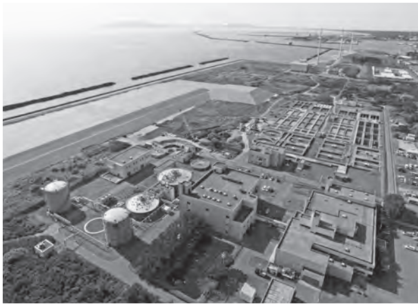
写真－1 秋田湾・雄物川流域下水道秋田臨海処理センター (左は日本海、奥に男鹿半島を望む)
