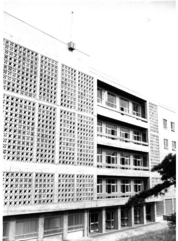
3号館正面外観（1962年竣工）
