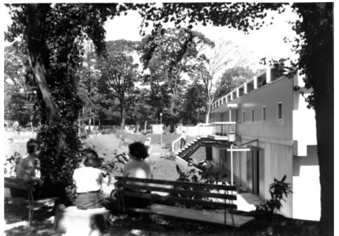
マシンホール（1965年竣工）
