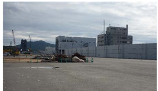
気仙沼港の内外を分ける鉄骨コンクリートの防壁
