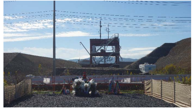
津波被災による鉄骨姿の南三陸町防災対策庁舎
