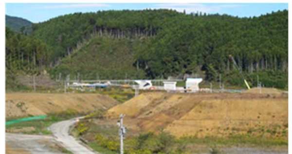
津波被災で消えた町の復興のための高い盛土
