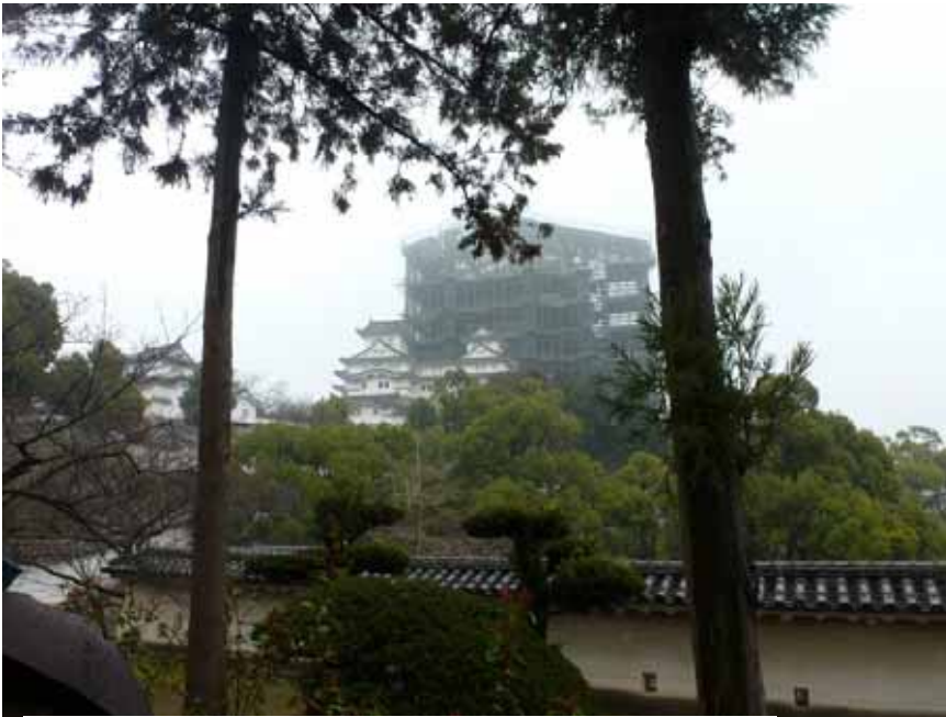
「改修中の姫路城天守閣 外枠が取り除かれ始めました」
