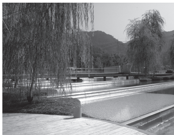
写真1 新見浄化センターカスケード
