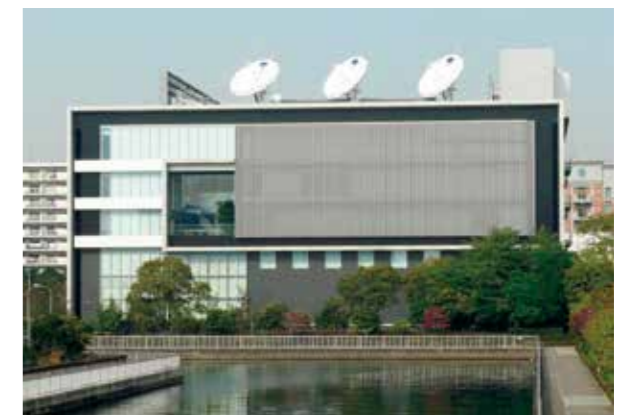
スカパー東京メディアセンター
