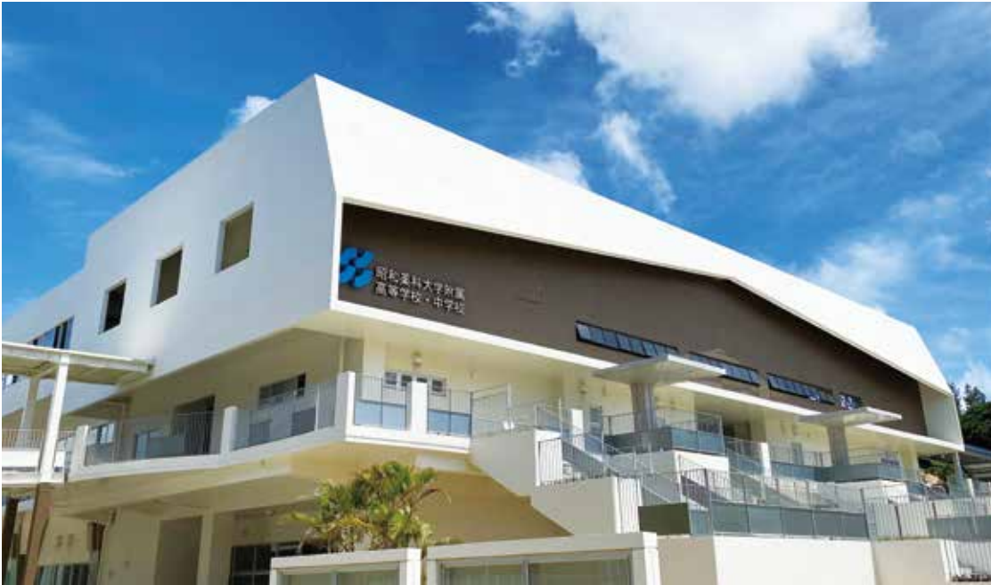
新第一体育館
