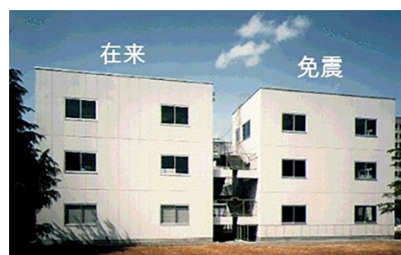
写真-14 東北大学免震実証試験建屋
