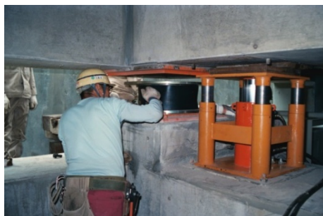
写真-15 積層ゴムの交換
