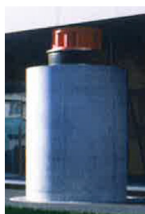
写真-16 柱頭免震
