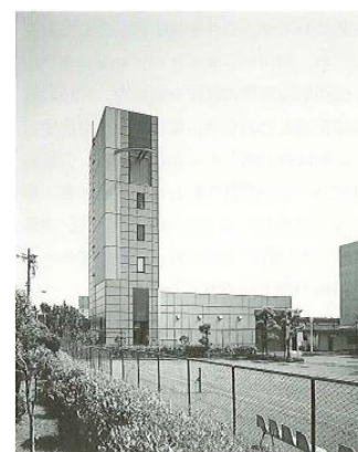
写真-3 遠心・制振実験棟
