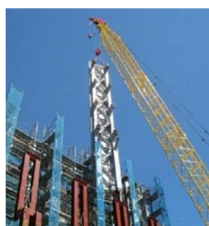
c.組柱・外壁の建方
