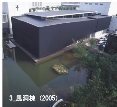
高層ビル群を街区単位で風洞実験し、最先端の測定装置で風の流れを視覚化できる実験棟。免震技術として世界初のパーシャルフロートを実証した。
