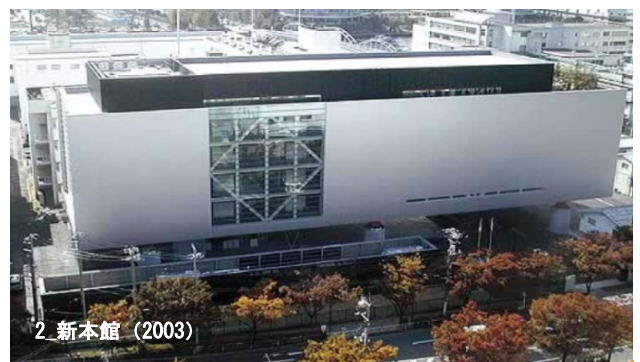
既存市街地やインフラを跨ぐ都市再生手法の確立と全館耐火設計、ドレンチャー水幕型防火区画、火災フェイズ管理型防災システム等、日本初の性能設計を実現建築の可能性を広げた。
