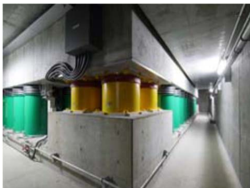
写真-6 空気ばねとダンパー
