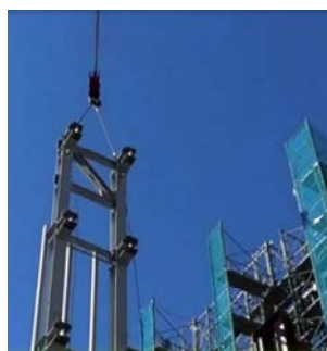
a.地組された組柱を仮置き場に設置
