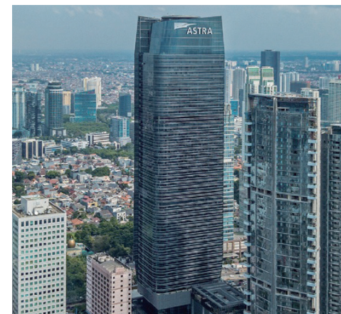
ASTRA Tower (インドネシア)
