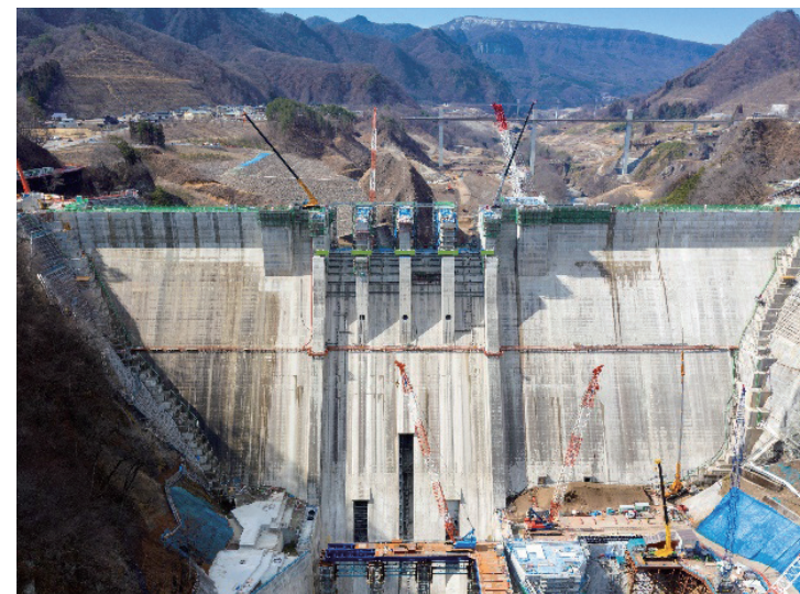
ハツ場ダム本体建設工事
