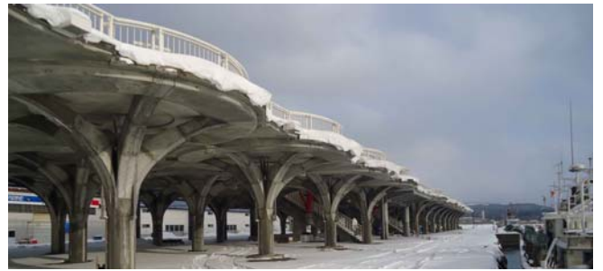
津波の際の避難場所となる人工地盤「望海橋」
