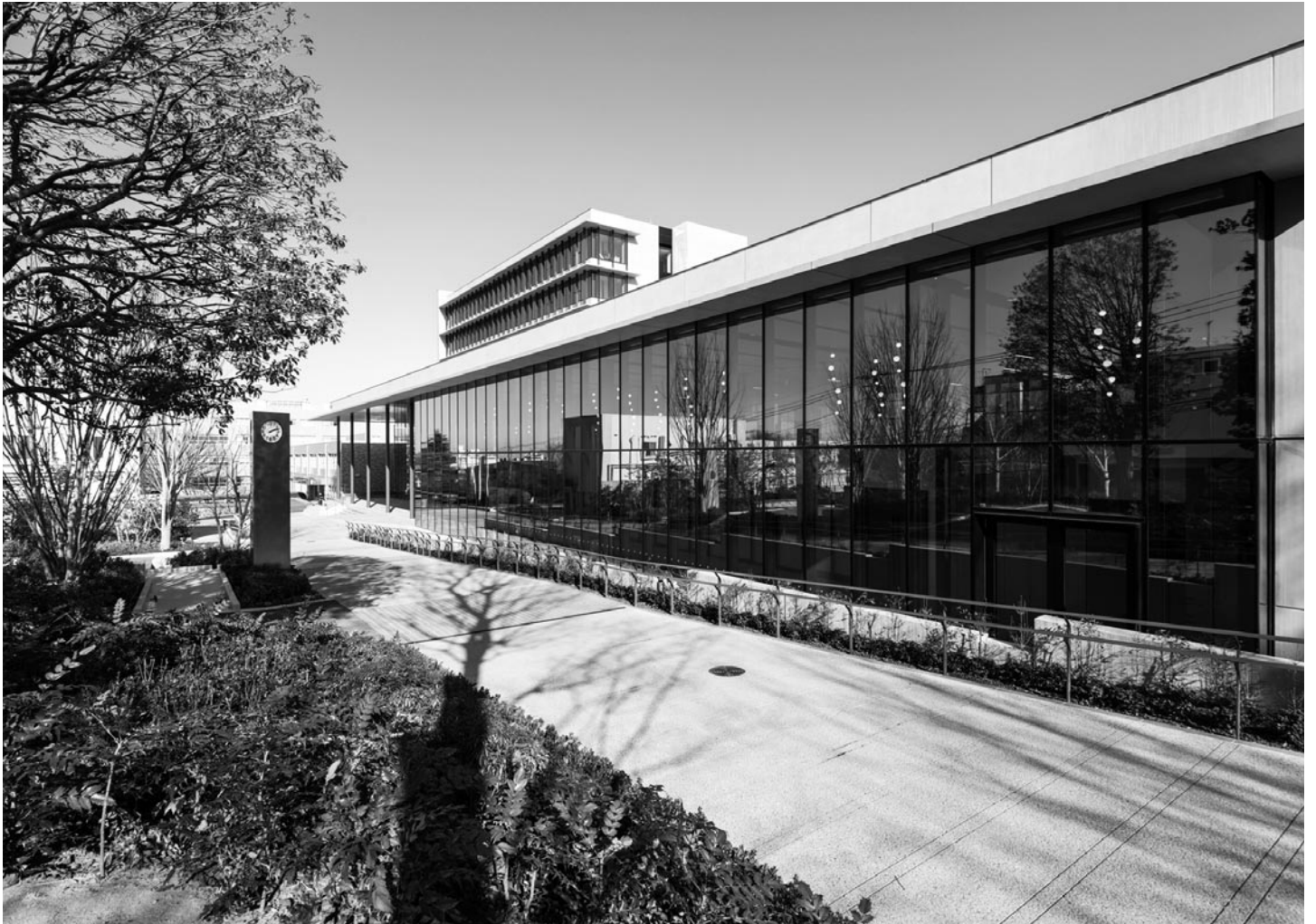
2号館3号館（奥）（生田キャンパス）
