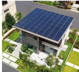
大容量太陽光発電システム
