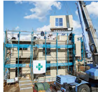
住宅ユニットの据え付け風景
