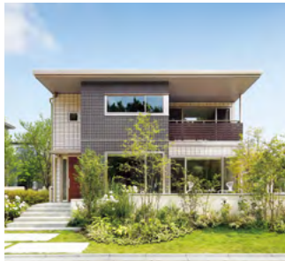
エネルギー自給自足を実現するスマートハウス「スマートパワーステーション」
