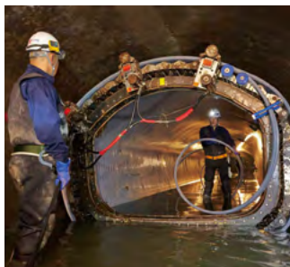
下水道管路更生
