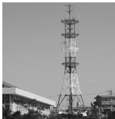
送受信所(おきなわTOWER内)
