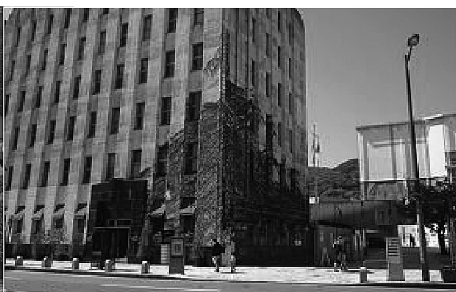
旧三井物産ビルと大規模修繕中の門司港駅舎
