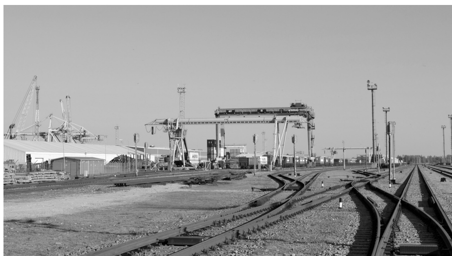
Figure 9. Terminal et train de conteneurs dans le port de Klaipeda
