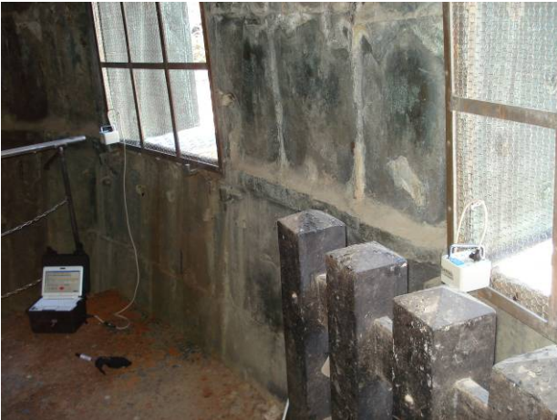
写真 3 大仏内背面窓の測定状況
