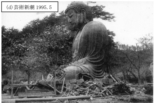
写真 5 大正関東地震による被災状況
