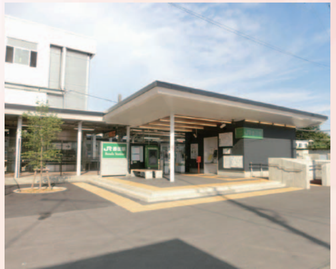
改修が完了した番田駅
