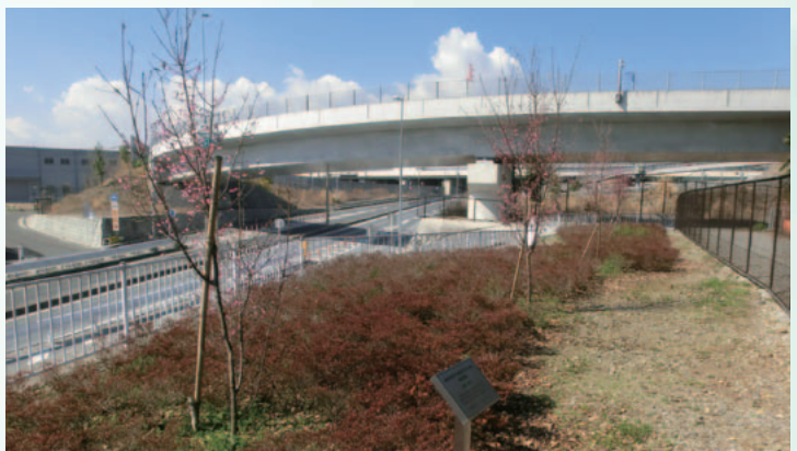
相模原愛川インターチェンジ付近
