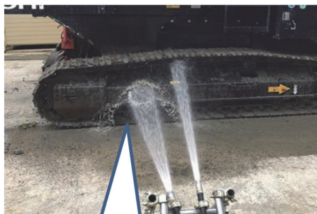
ストレート散水状態。
