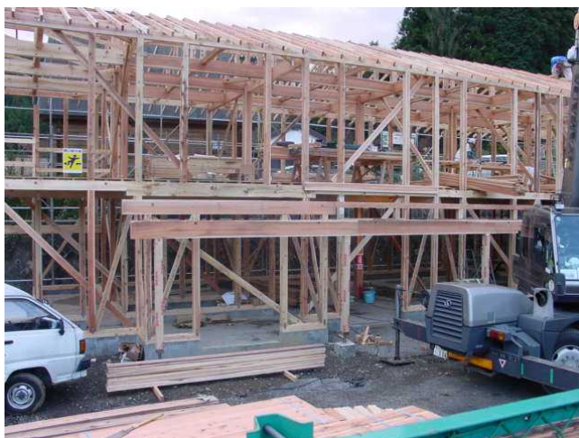
木造軸組状況
