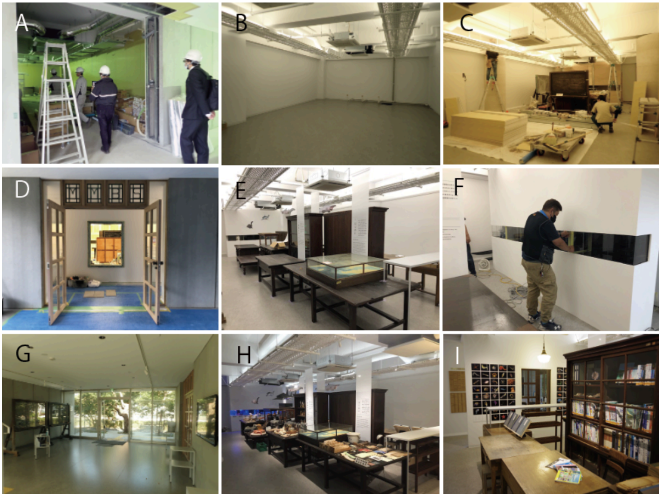
図9. 展示室 海のショーケースのできるまで. A: 建設中の展示室. B: 受け渡し後の展示室. C: 7月に入ってから展示室. D: 作成中の展示室入口. E: 木製什器類を搬入した展示室. F: 水槽を設置. G: 完成したエントランスホール. H-I: 完成した展示室 海のショーケース.
