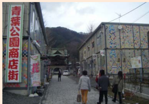
釜石市青葉公園仮設商店街
