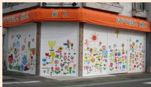
宮古市駅前商店街に設けられた事務所。シャッターがカラフルに彩色されている。 ※写真は被災地障害者センターみやこのHPから転載
