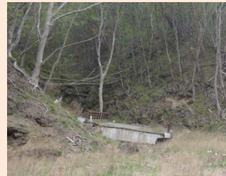
震災後：漁港上流域の宮古市重茂与奈地区は河口から500mまで津波が押し寄せ、森林面積約3haに被害。むき出しの林地に橋が乗り上がっている。
