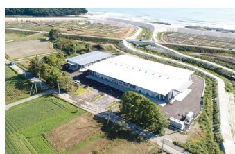
2020年10月に完成した国内最大規模のサツマイモ貯蔵施設
