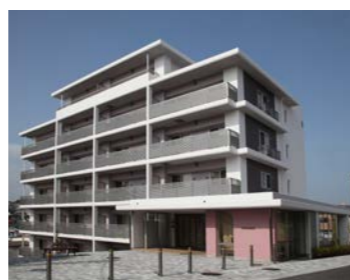
復興公営住宅の例
