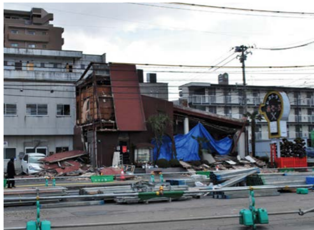
被災した木造住宅
