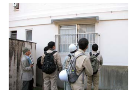
PC建築の集合住宅の損傷状況を確認するPC建築部会調査隊 (UR都市機構合同調査)
