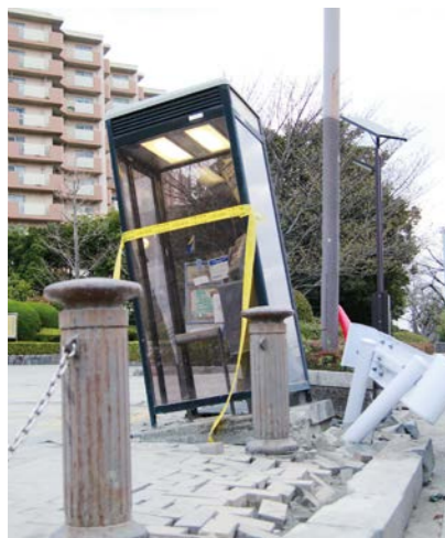
地盤沈下で破損した歩道
