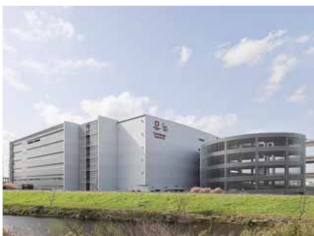
PS-PC工法+免震工法(マルチテナント型物流倉庫)
