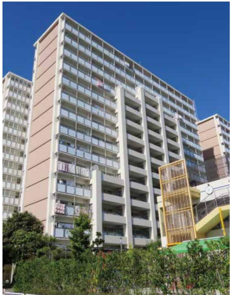
PCアウトフレーム耐震補強
