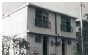
トヨタT&S建設
