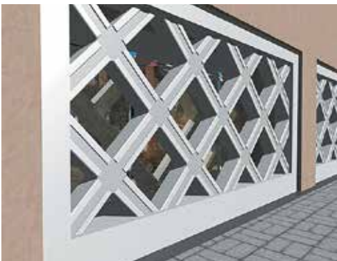
プレキャスト格子ブロックによる耐震補強
