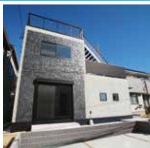
トヨタT&S建設
