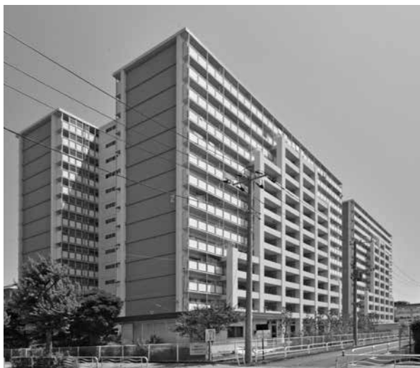
都営アパート耐震改修工事
