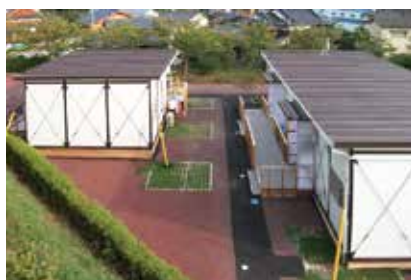
2012年 九州北部豪雨災害 福岡県八女市
