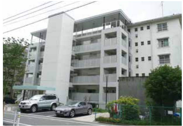
エレベーター・外廊下増設
