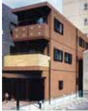
トヨタ T&S 建設
