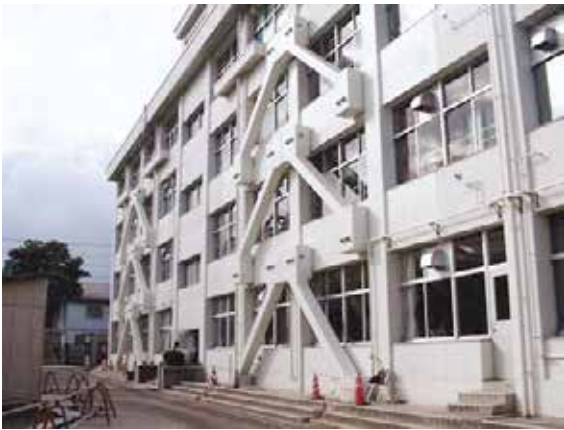
PCブレースによる耐震補強
