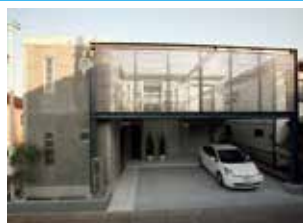
トヨタ T&S 建設
