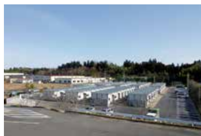
2019年 令和元年東日本台風災害 宮城県丸森町
