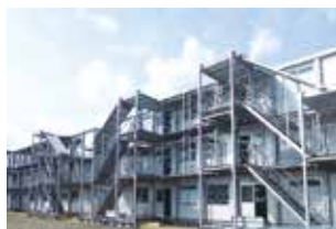
仮設現場事務所
