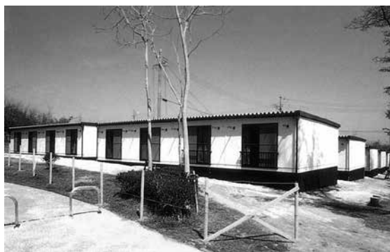
阪神・淡路大震災で建設した応急仮設住宅
