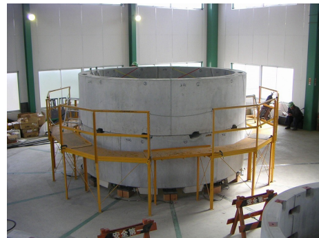
写真-2 水平仮組試験状況
