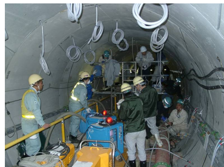
写真-6 グラウト注入状況
