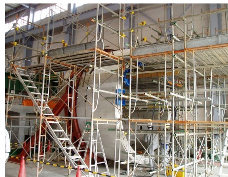
写真-3 鉛直仮組試験状況
