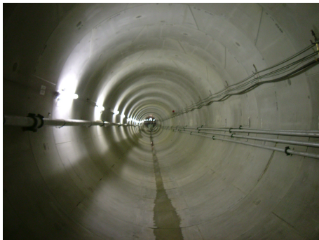
写真-1 施工完了状況
