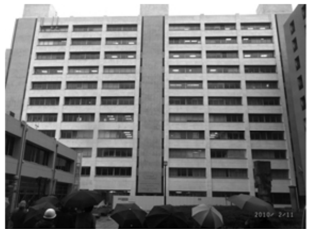
雨の中でのロックング壁の見学(中央及び両端の壁)
