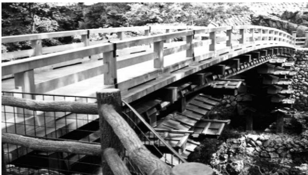
橋梁側桁面より
