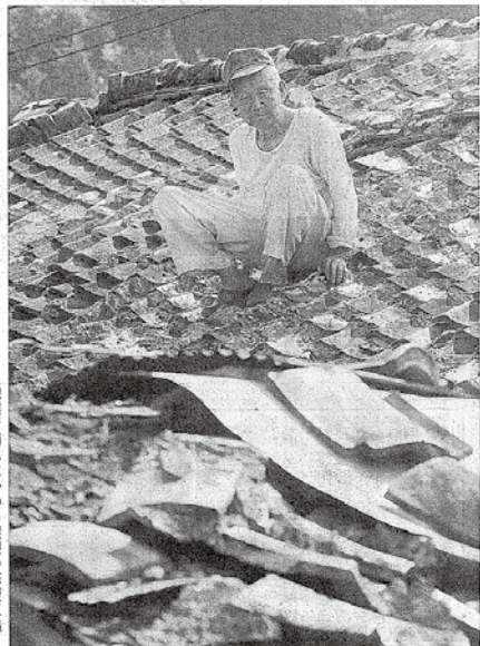
地震で崩れたから屋根の修復に追われ、しゃがみ込むお年寄り。7日午前10時16分、鳥取県日野町
