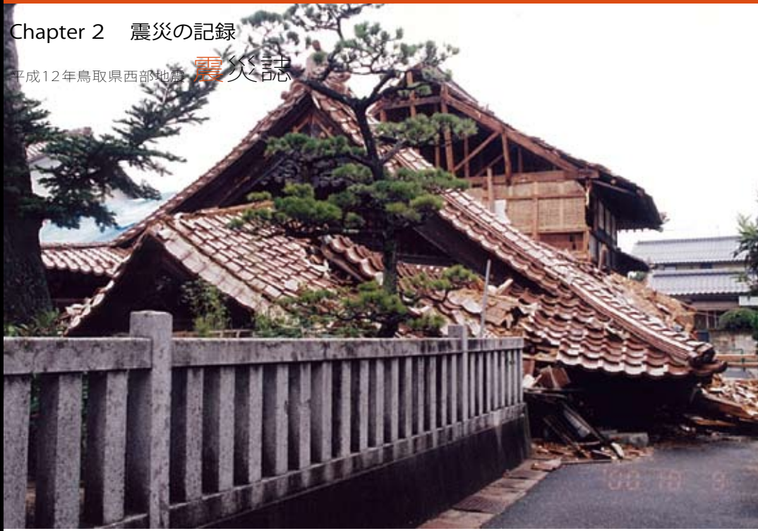
地震で倒壊した出雲大社上道教会（境港市）
