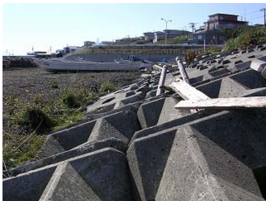
写真－3 えりも岬漁港津波痕跡
