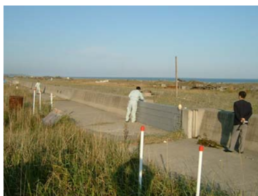
津波対策用陸閘
