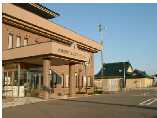
避難所（大津コミュニティーセンター） 奥に仮設トイレが5基設置されていた。
