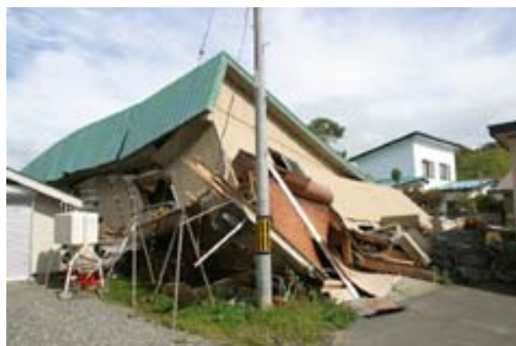
浦河町 東町地区 倒壊した倉庫
