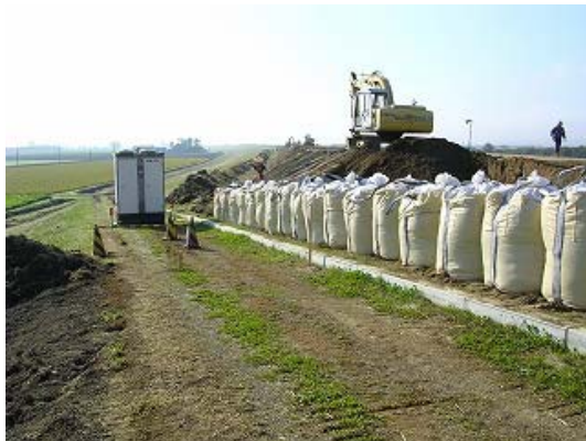
写真一17 利別川 緊急復旧工事
