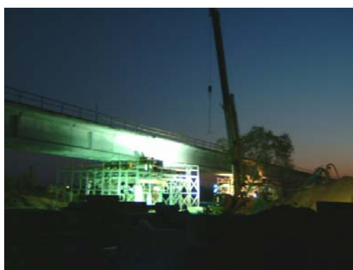
JR北海道 根室線 利別川橋梁復旧工事
