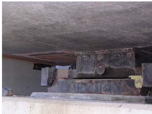
写真-1 4 十勝河口橋 支承部
