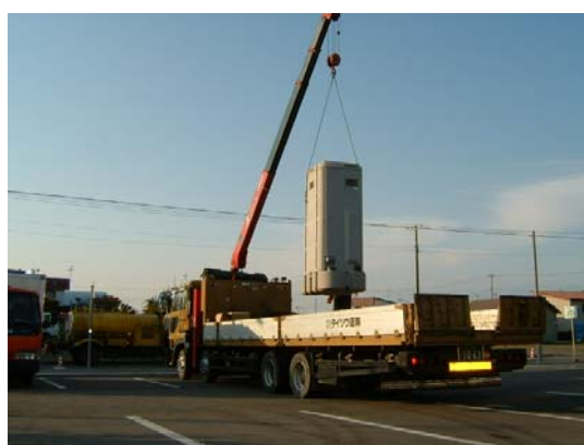
仮設トイレの撤去風景
