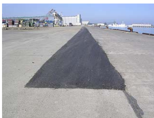
写真一8 十勝港 応急復旧のすりつけ
