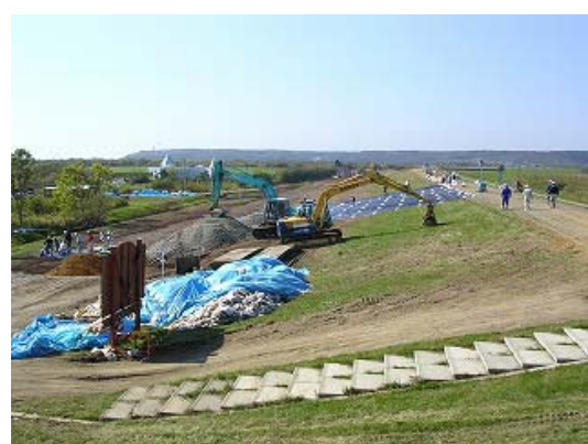
写真一20 十勝川 河口部緊急復旧工事
