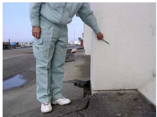
写真—24 大津漁港 津波浸水高
