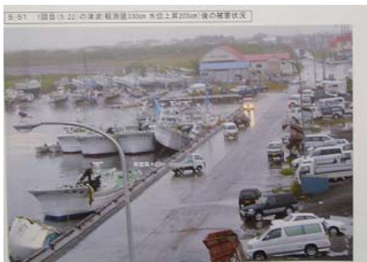
写真—25 大津漁港 1回目の津波後の状況
