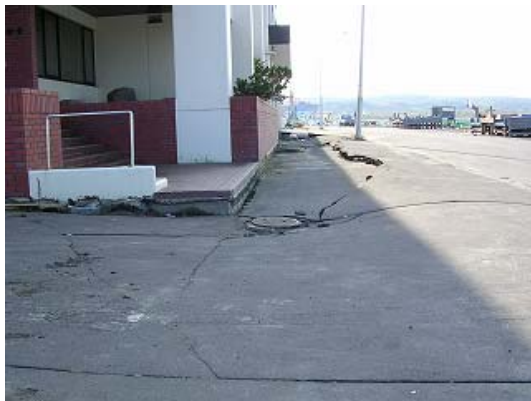
写真—23 大津漁港 漁協前地盤沈下
