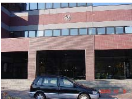
釧路町役場の玄関車寄せの屋根が倒壊（改修後）
