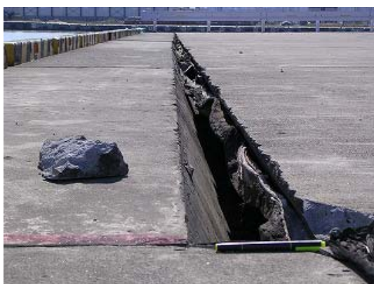
写真一7 十勝港 エプロン離れ
