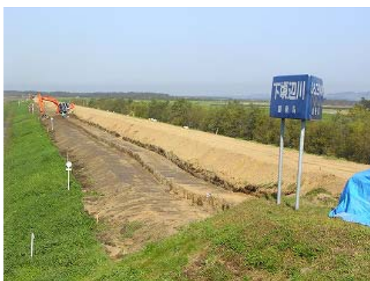
写真一19 下頃辺川 緊急復旧工事
