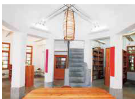
1階中央スペース。八角形の2階を支えるための柱は変則的な五角形をしています。
