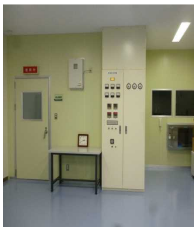
TSE検査室 外観
