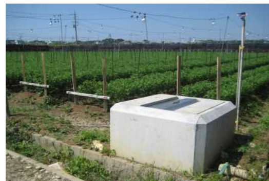
給水栓を設置（Ⅱ型整備）
