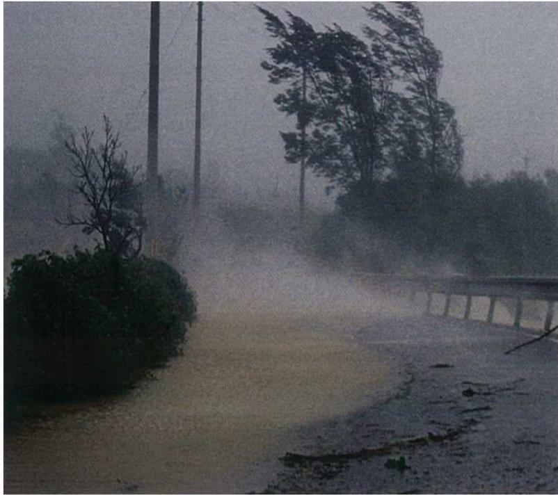
台風による越波で背後農地が被害
