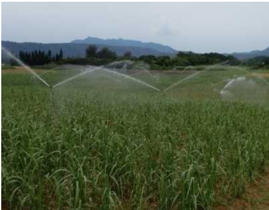
スプリンクラーを設置（Ⅰ型整備）
