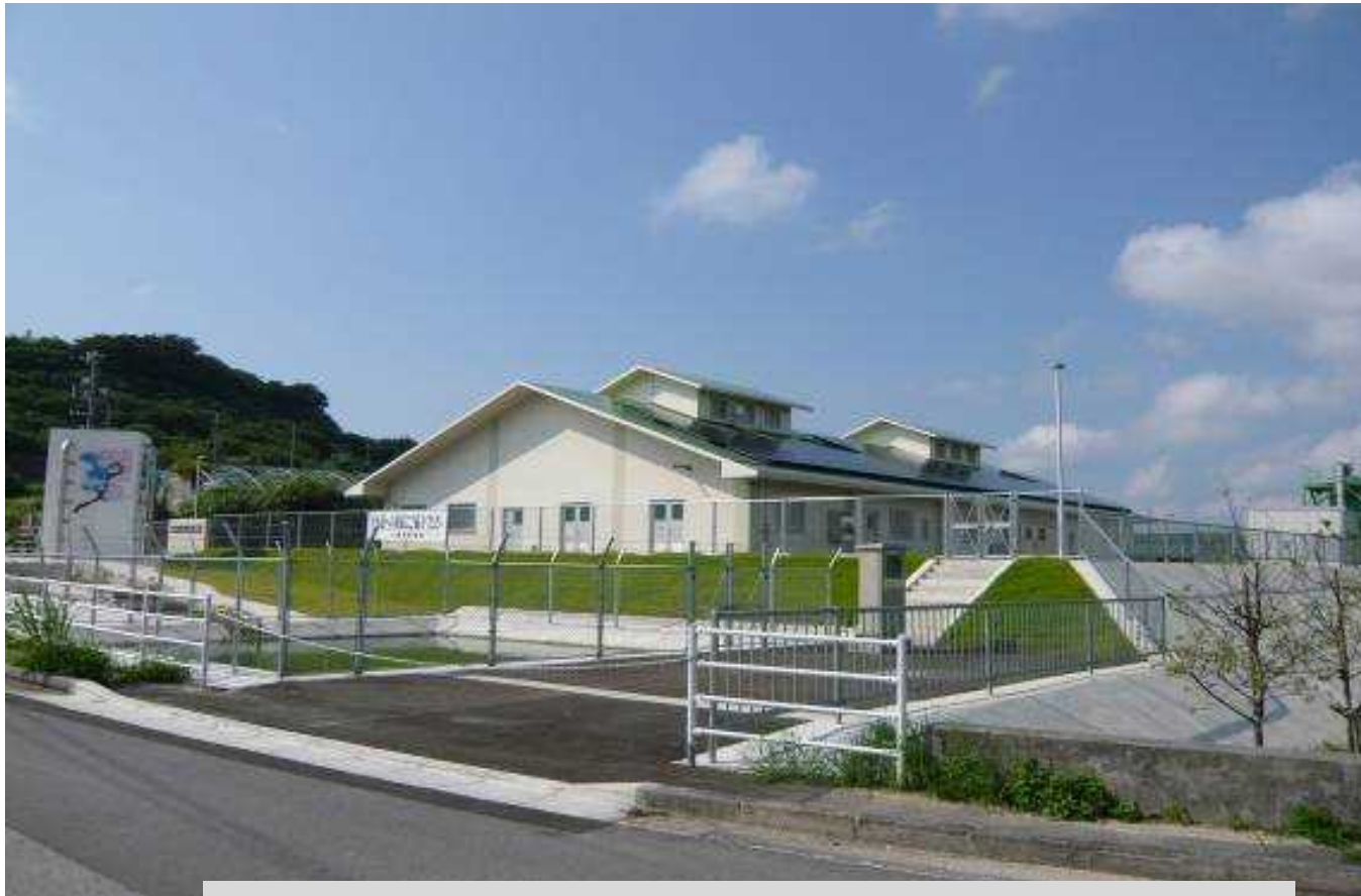
污水处理施設（農業集落排水施設）
