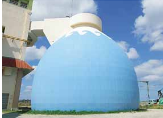
汚泥消化タンク
